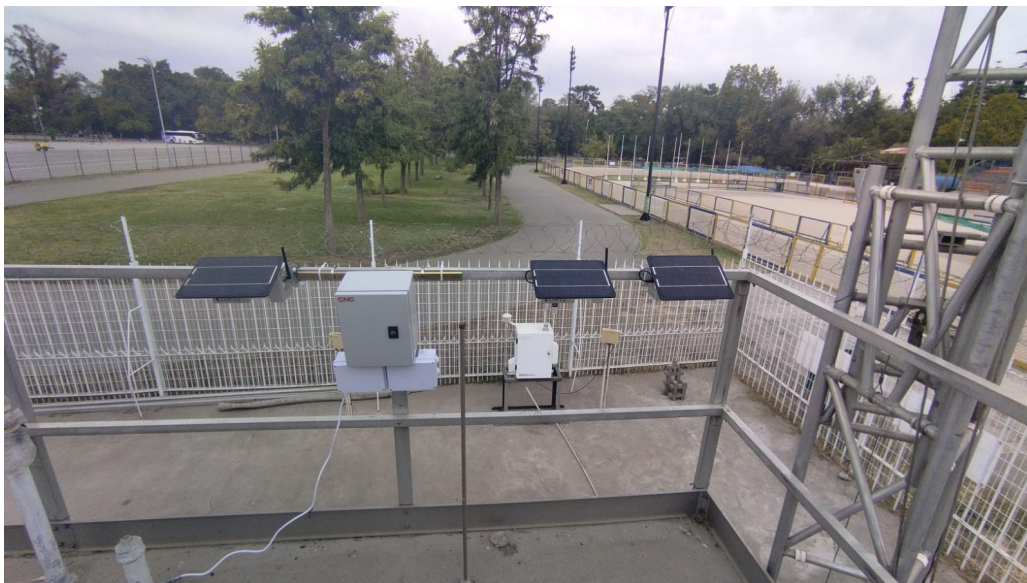
Figura 4.3: Colocación de dispositivos en Estación de Monitoreo del SINCA en Parque O'higgins. Los tres dispositivos con paneles solares negros son sensores del proveedor Clarity. El dispositivo con el gabinete eléctrico gris corresponde al prototipo con los sensores de bajo costo diseñado para el Producto 5.
